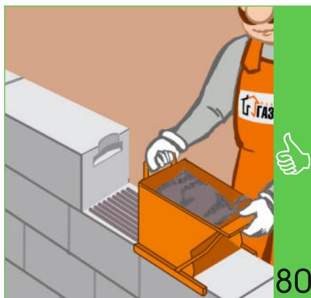
**Каретка для клеевого раствора** предназначена для нанесения клея на горизонтальную поверхность блоков во время кладки. Каретка позволяют дозировать клей, обеспечивая одинаковую толщину шва по всей кладке. Наиболее продуктивно использование кареток при кладке длинных и прямых стен. Выпускается шириной 300 и 400 мм
