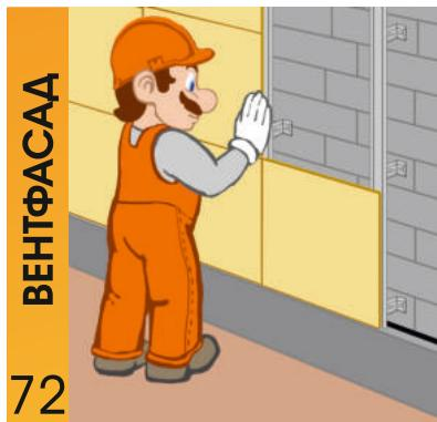
Установка панелей на систему навесного вентилируемого фасада
