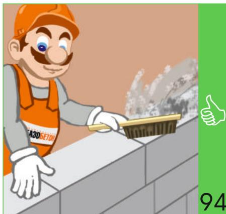
Щетка-сметка предназначена для очистки поверхности от пыли. Применяется после штробления блока, перед грунтовкой и окраской поверхности стен
