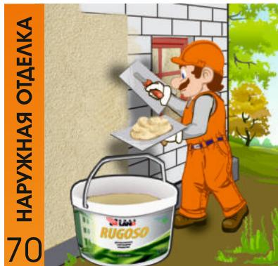
После высыхания грунтовки нанести на стену заранее заколерованное текстурное покрытие **RUGOSO** используя хоппер-пистолет, шпатель или кельму. После нанесения сформировать необходимый рельеф
